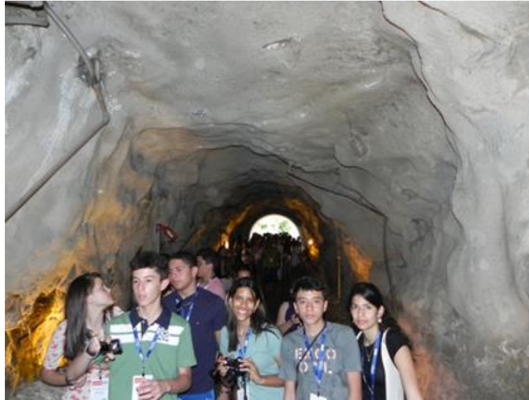
Figura 02 – Hidrelétrica de Paulo Afonso III – Sistema Abrigado
