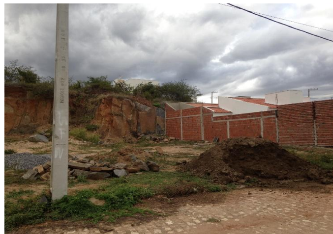
Figura 3 Área de Desmoronamento
