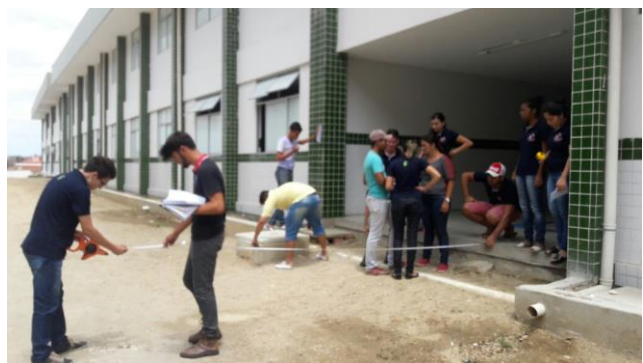
Figura 05 – Primeiras medições realizadas para dimensionamento de rampa. Fonte: Autores, 2017.
