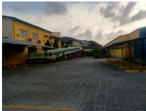
Figura 3. Estacionamento coberto interno do Instituto Frei João Pedro de Sexto.
