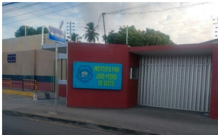
Figura 1. Entrada do colégio na Avenida Frei Cirilo.
