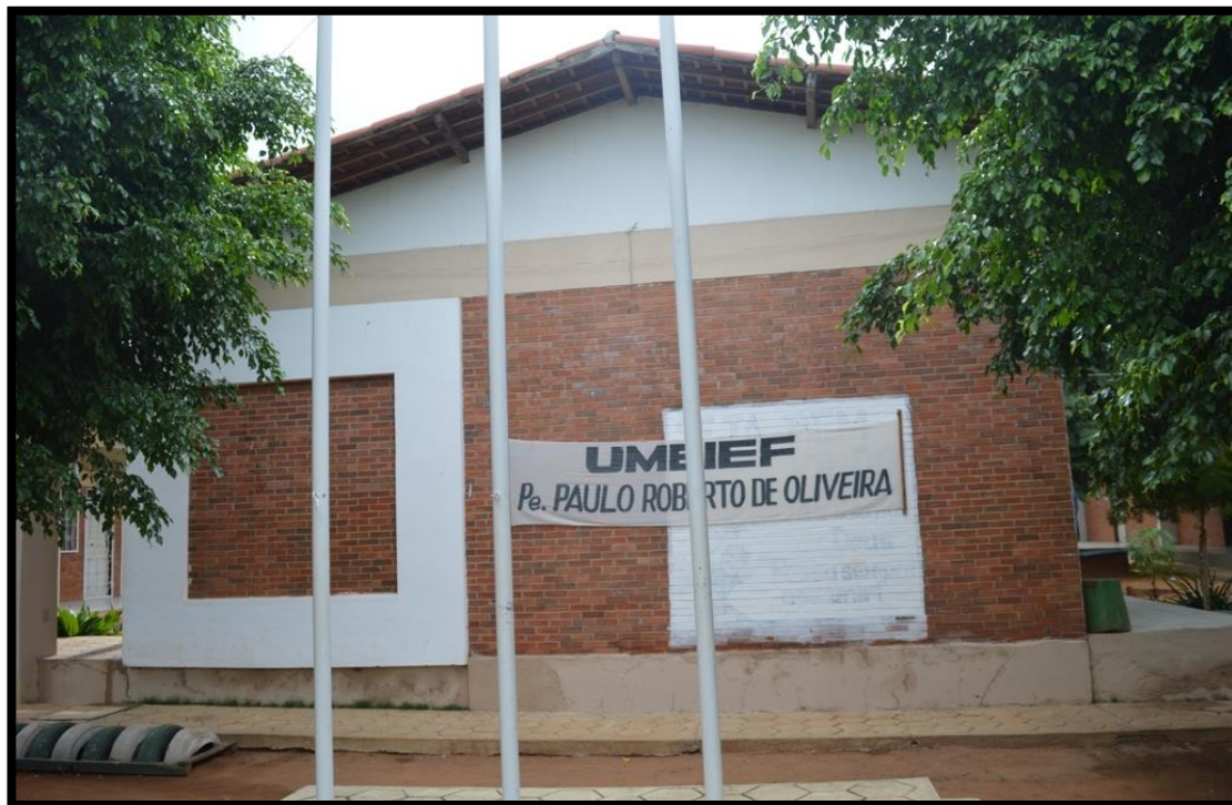
Figura 2 – Escola Municipal Padre Paulo Roberto de Oliveira, situada na cidade de Sumé – PB, no Bairro Frei Damião.
