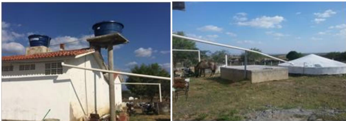
Figura 3 - Cisterna com sistema de captação de água da chuva na escola municipal de Queimadas - PB.
