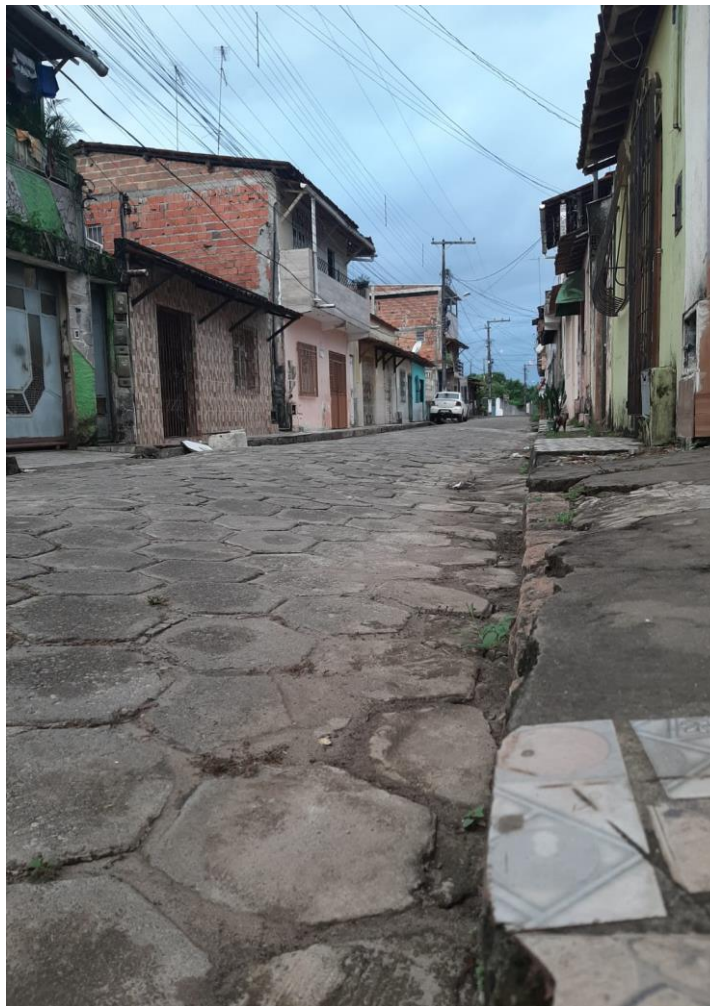
Rua no Bairro do Tento – Valença/Ba Foto: Patrícia Moreira, 2021
