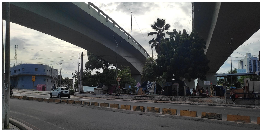
Figura 2 - Moradores de rua situados abaixo do Viaduto do Baldo.
