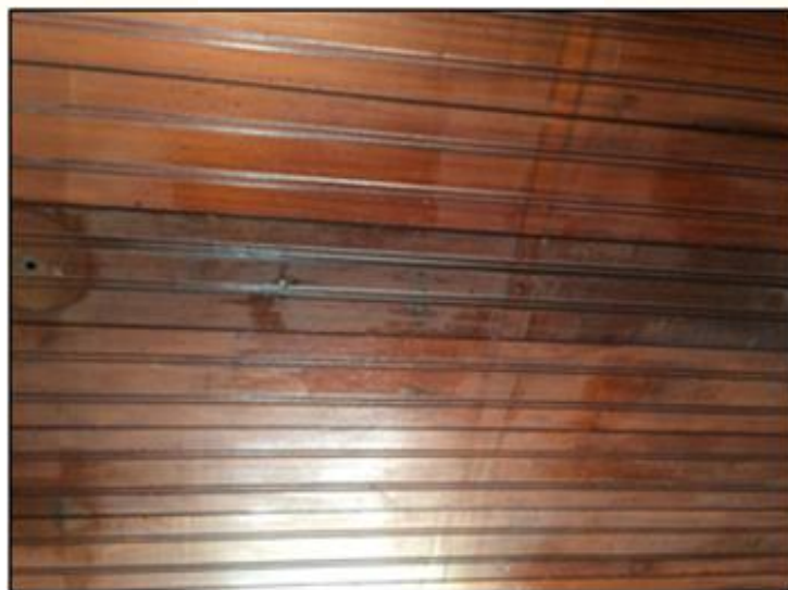
Figura 6 – Infiltrações.
