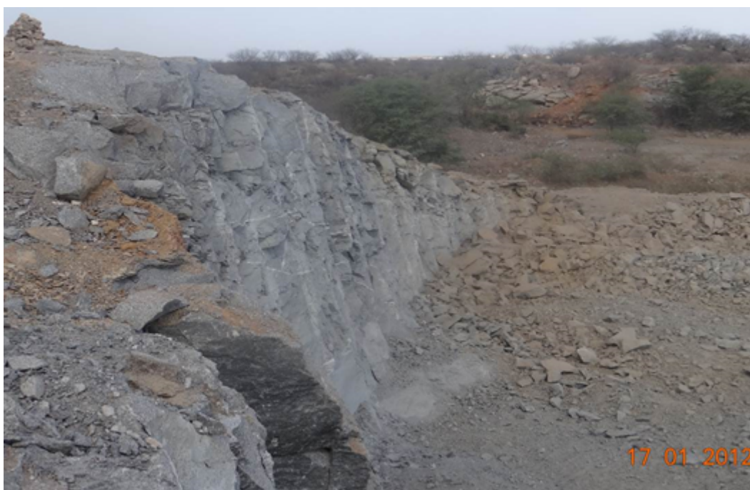
Figura 2. Talude remanescente da Mineração Dantas Gurgel & Cia Ltda desmontado com uso de espoleta eletrônica.
