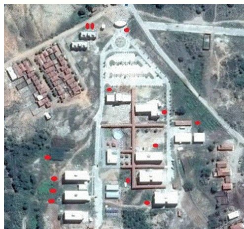
Figura 3 – Localização das fossas sépticas.
