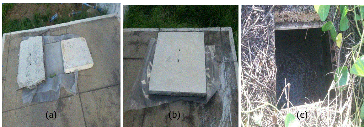
Figura 4 – Fossas sépticas localizadas ao lado da biblioteca
