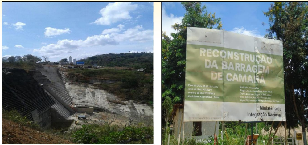
Figuras 04 e 05: Barragem sendo reconstruída e placa sobre a reconstrução da Barragem Camará. Fonte: Arquivo dos autores, 2016.
