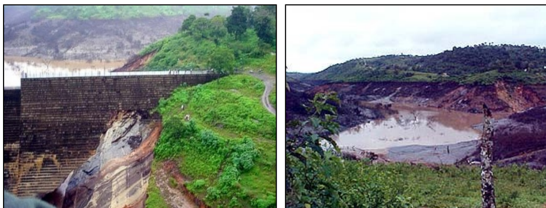
Figuras 02 e 03 – Rompimento da Barragem de Camará. Fonte: Brejo.com, 2004.
