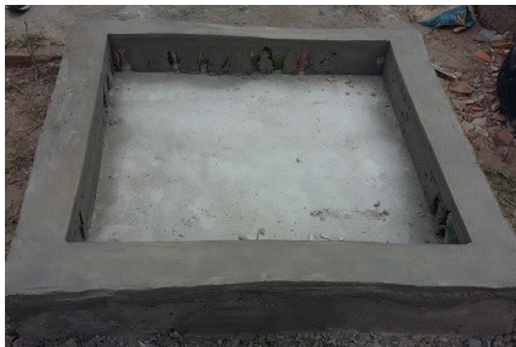
Figura 6 - AcquaPET com a etapa de cimentação quase concluída.
