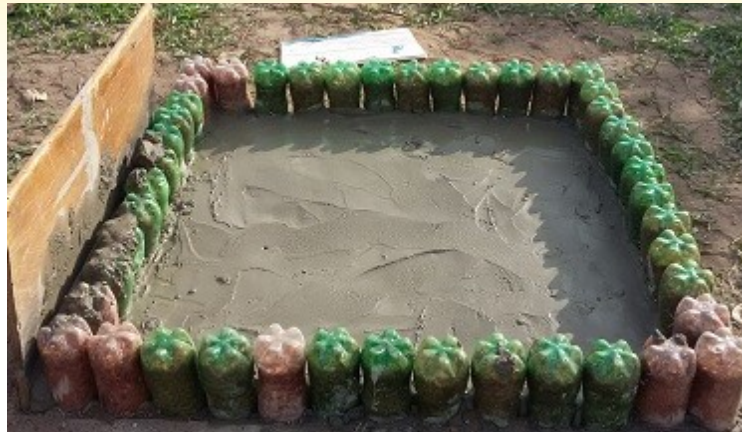
Figura 5 – AcquaPET com a etapa de cimentação em andamento.
