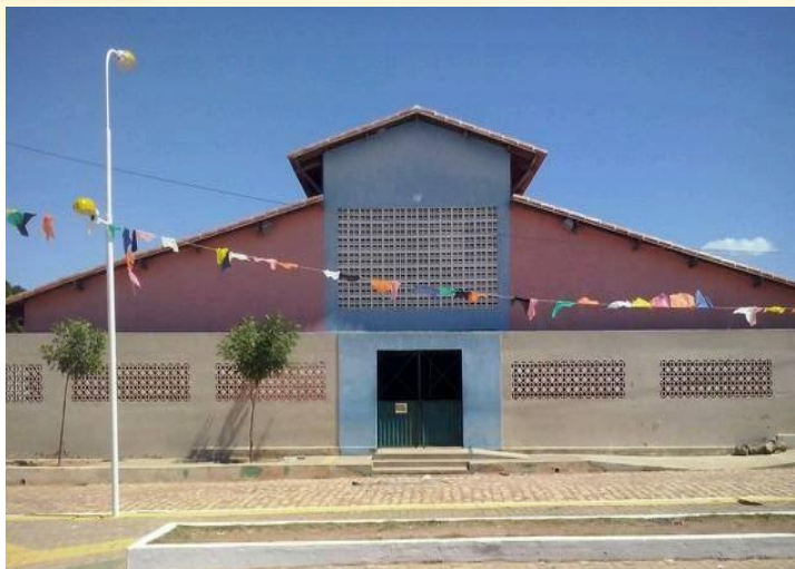
Imagem 01: fachada da Escola Municipal Vila Rio Grande do Norte Fonte: Pesquisa de Campo, 2016.
