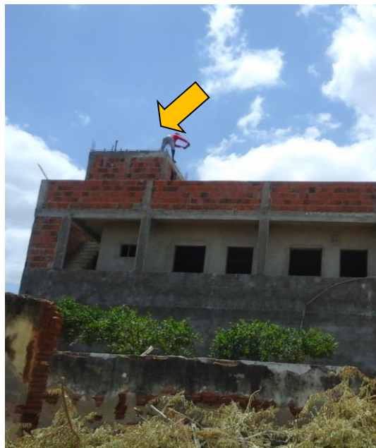
Figura 01 – Trabalho em altura
