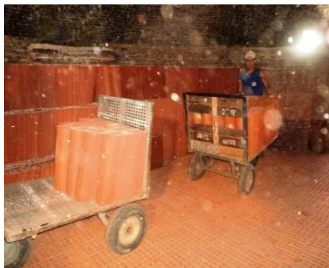
Figura 12. Desenformamento de telhas nos fornos abóboda
