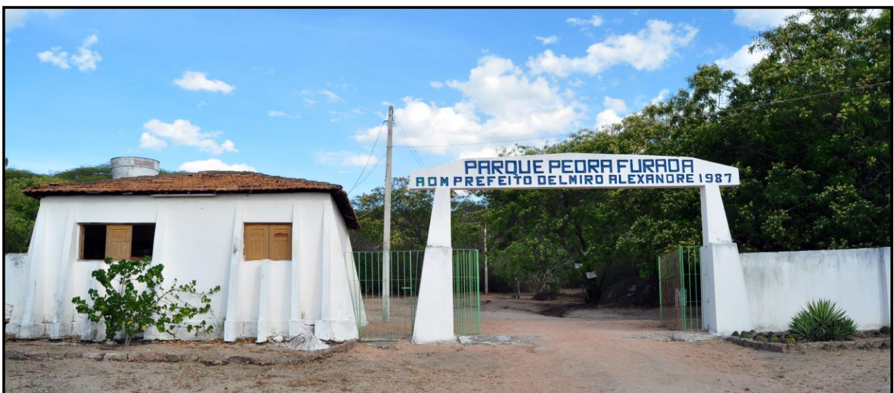
Figura 2. Estrutura de entrada do Parque Pedra Furada. Município de Venturosa – PE. Fonte: Autores, 2016.
