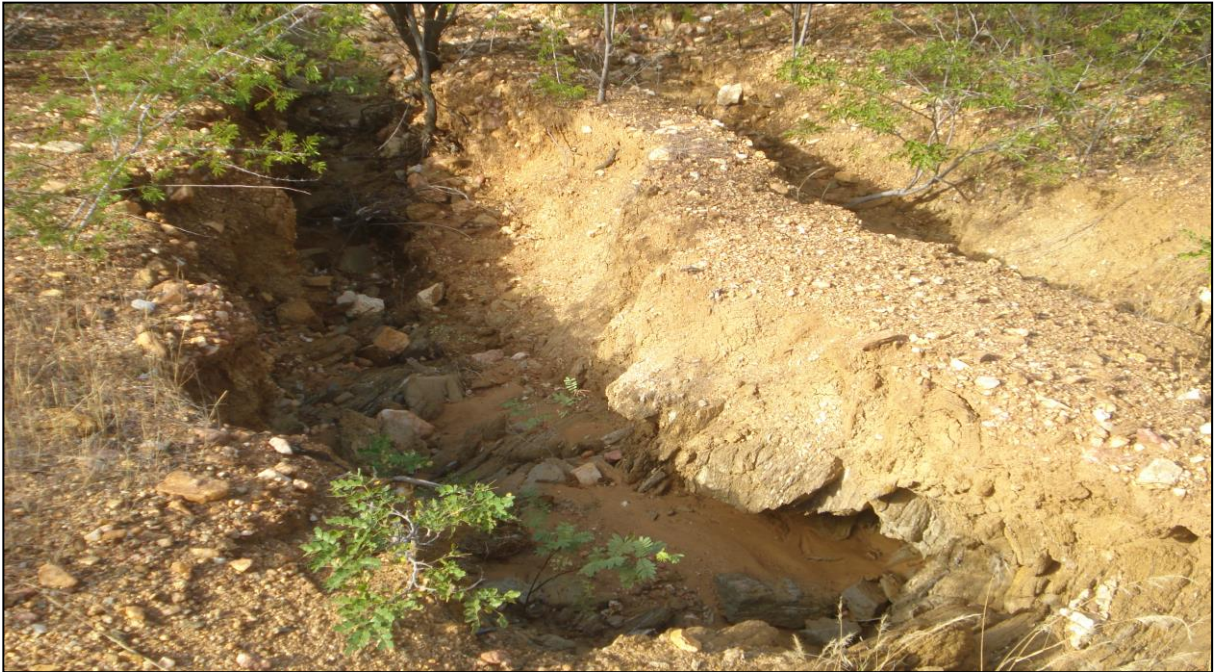
Figura 2 – Erosão do solo na comunidade Currais Novos
