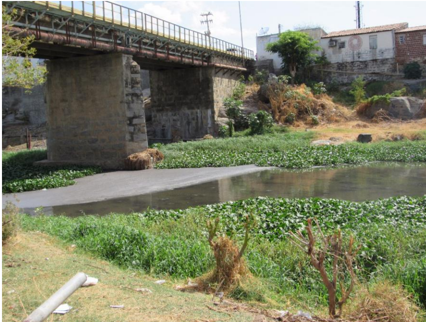
Figura 02 - Parte do rio com ponte de acesso
