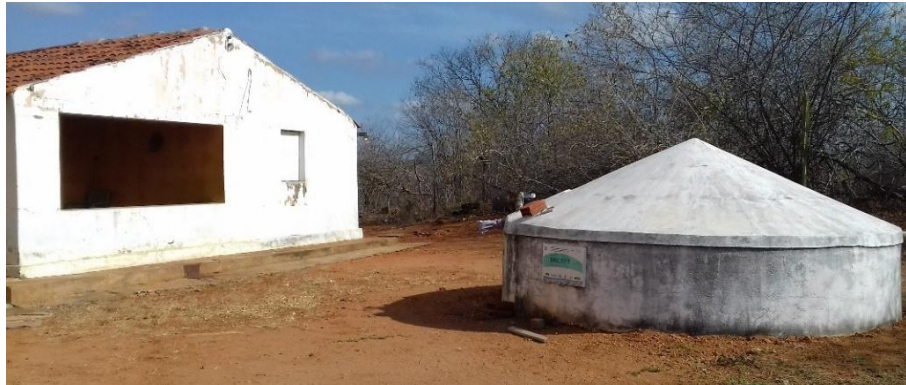
Figura 01. Cisterna utilizados por moradores na captação de água das chuvas.
