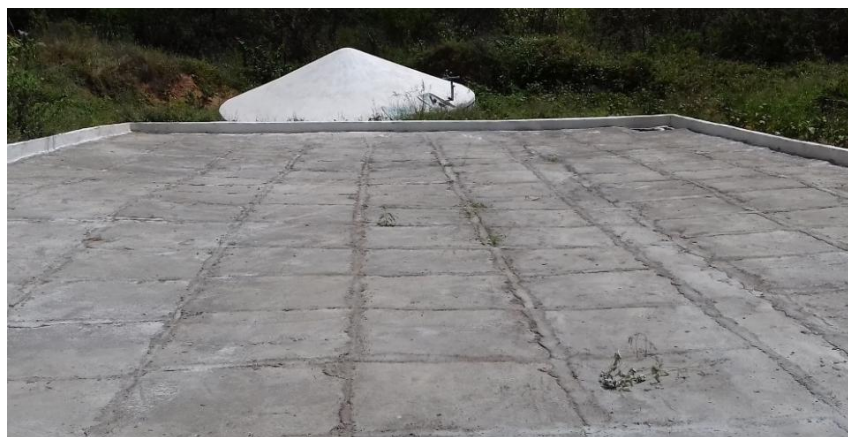
Figura 02. Cisternão de calçadão.
