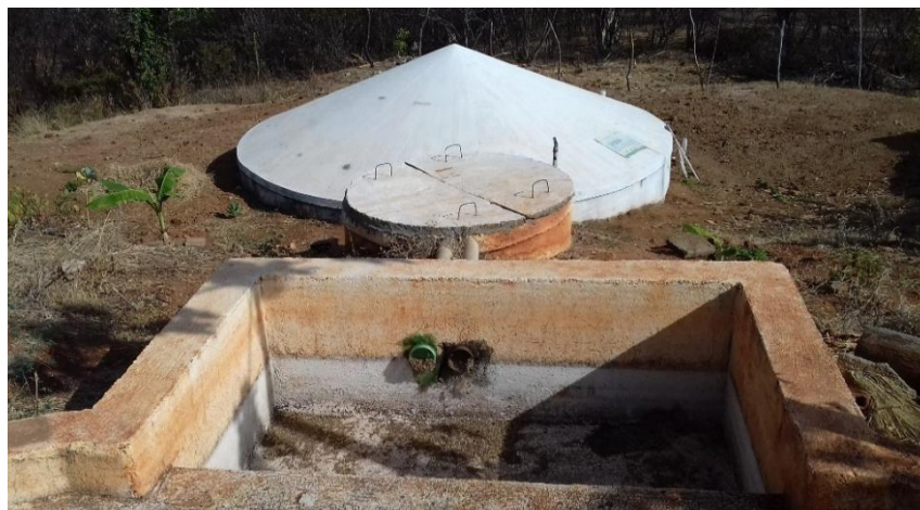
Figura 03. Cisternão de enxurrada
