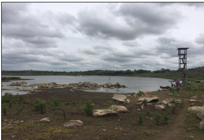
Figura 4. Barragem de Campo Grande, segundo ponto de coleta de dados. Fonte: Os Autores, 2016.
