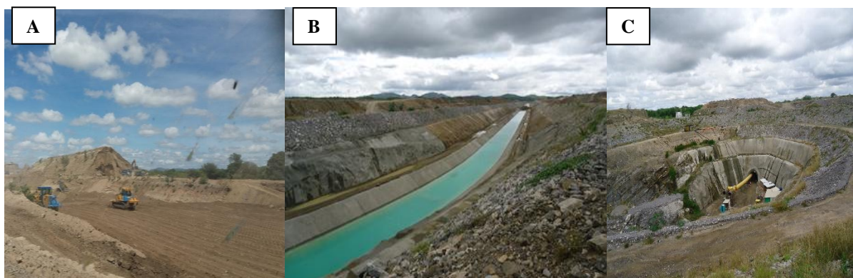
Figuras 1: Áreas de perda e fragmentação da vegetação no Canteiro de Obras: A – Galerias Fechadas / B- Canais Abertos/ C- Túnel
