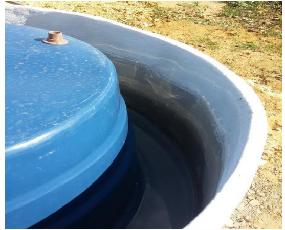
Figura 13: Selo d'água. Fonte: Produção dos autores.
