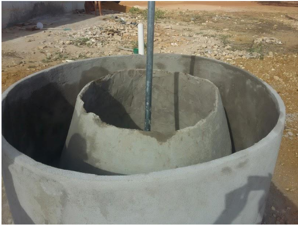
Figura 12: Detalhe do cone e selo d'água. Fonte: Produção dos autores.
