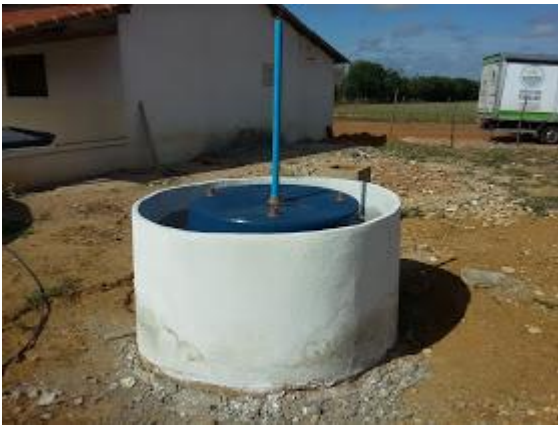
Figura 14: Vista da campânula e selo d'água. Fonte: Produção dos autores.
