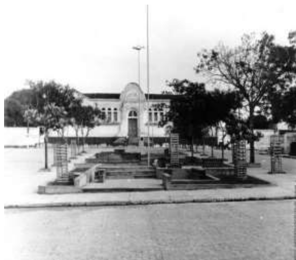
Figura 2: Início da construção da Praça da Cultura.
