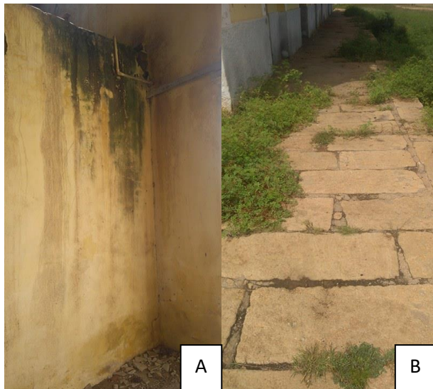
Figura 6- Estrutura com proliferação de (A) Bolor (B) Plantas.
