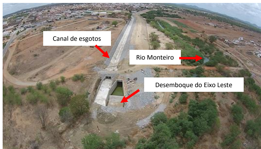
Figura 4. Vista do canal de drenagem de águas superficiais e de esgotos aos arredores da cidade de Monteiro e o encontro na desembocadura do canal de Transposição do Eixo Leste.
