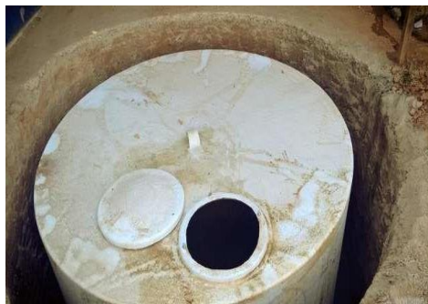
Figura 7: Cisterna de Fibra de Vidro. Fonte: SEDINOR, (2016).
