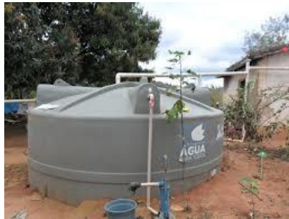
Figura 6: Cisterna de Polietileno. Fonte: SEDINOR, (2016).
