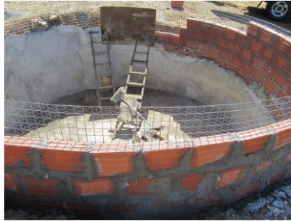
Figura 4: Cisterna de tijolos. Fonte: XICLIVISTA, (2011).
