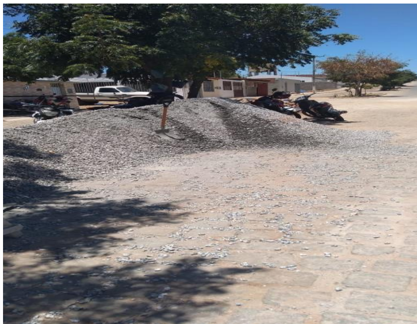
Figura 01: Obra visitada em Sumé
