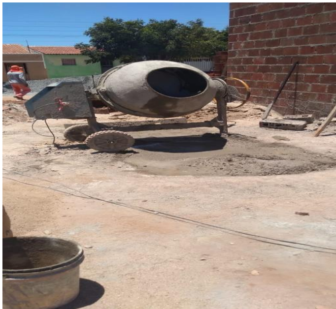
Figura 02: Obra visitada em Sumé
