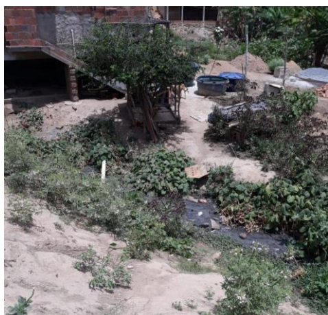
Figura 5 - Esgoto correndo a céu aberto.
