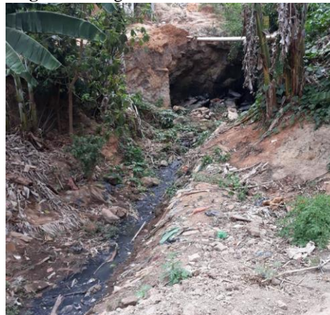
Figura 4 - Esgoto correndo a céu aberto.
