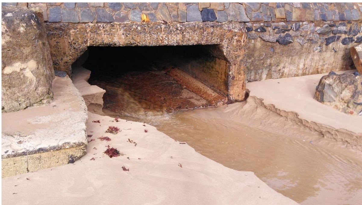
Figura 1: Rede de drenagem com fonte duvidoso de água na praia de Manaíra – João Pessoa/PB
