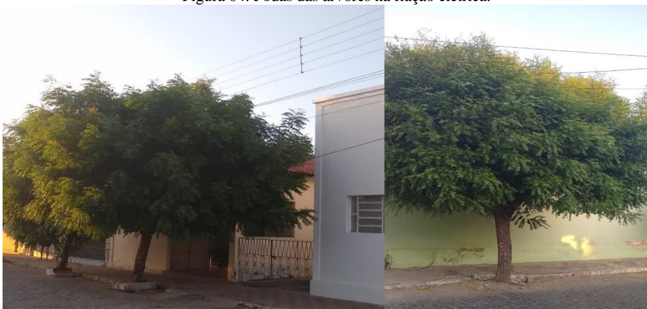
Figura 04. Podas das árvores na fiação elétrica.
