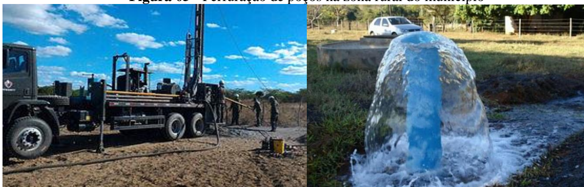
Figura 05 - Perfuração de poços na zona rural do município
