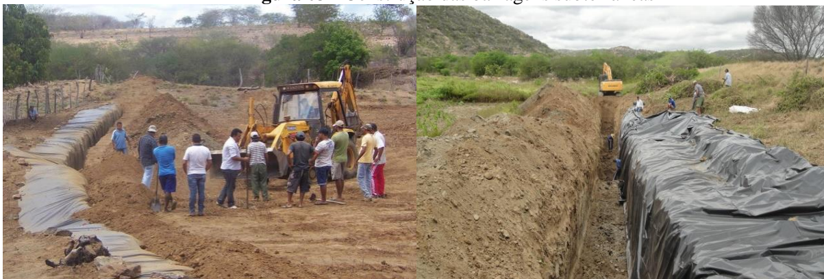
Figura 03 - Construção das barragens subterrâneas
