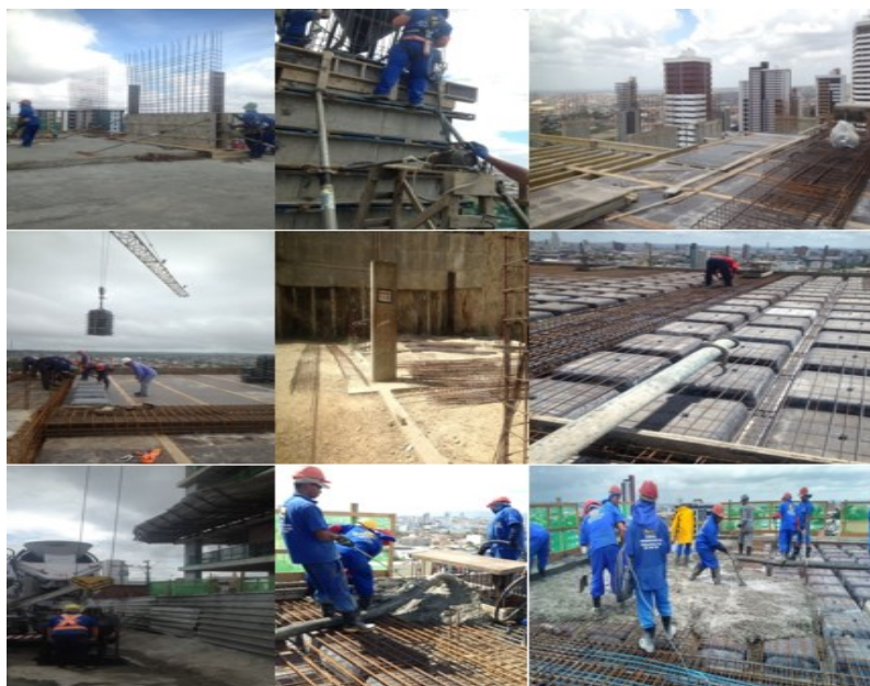
Figura 1 – Equipe de trabalhadores desenvolvendo atividades do ciclo da laje.
