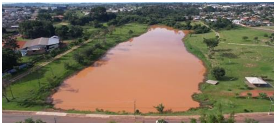
Fig. 5 – Vista da lagoa de jusante para montante em perspectiva
