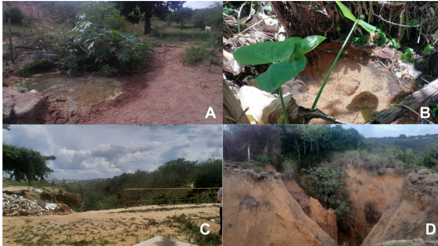
Figura 2: A: Surgência da Nascente Vila Maria.; B: Afloramento da Nascente Pau Pombo; C: Encostas aterradas com lixo na Nascente Pau Amarelo; D: Voçoroca próxima a Nascente Arco Íris
