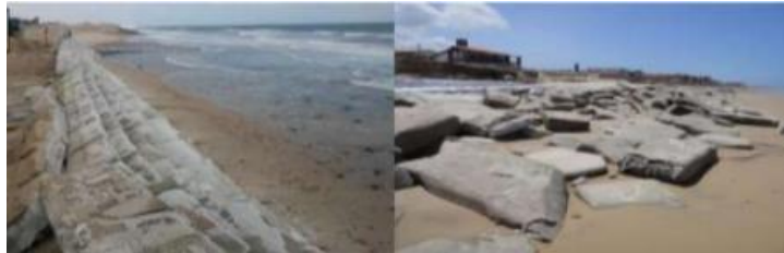
Figura 1 – Estruturas de contenção do tipo bagwall na praia de Icaraí (2015)
