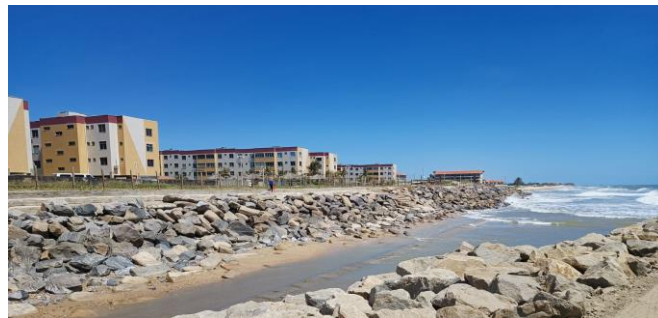
Figura 2 - Enrocamentos na praia de Icaraí.
