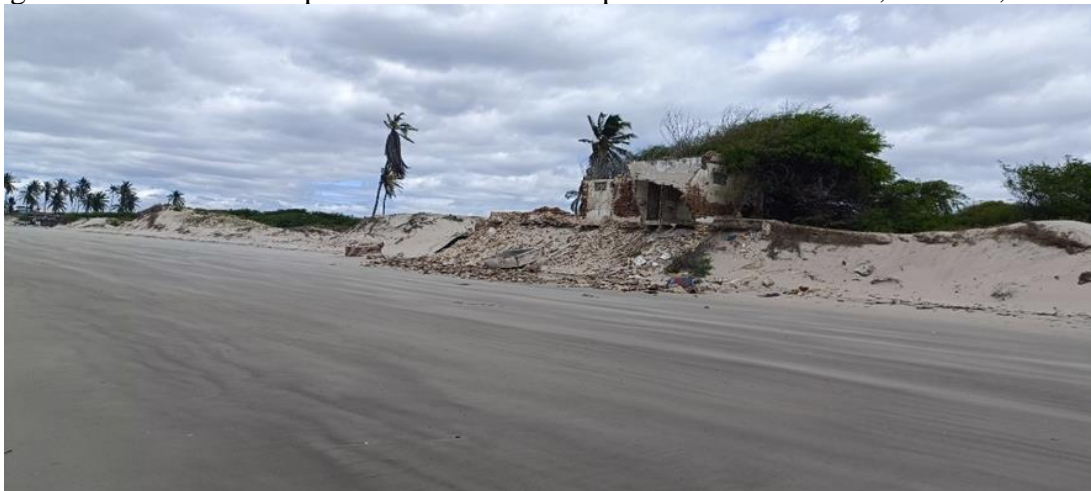
Figura 4: Casa destruída pela erosão costeira na praia de Areias Alvas, Grossos, 2024.
