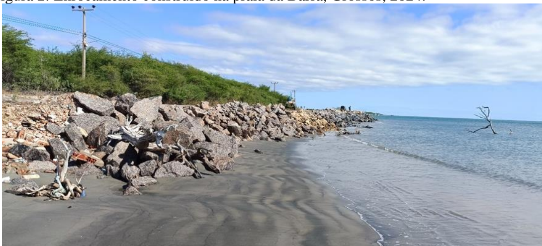
Figura 2: Enrocamento construído na praia da Barra, Grossos, 2024.
