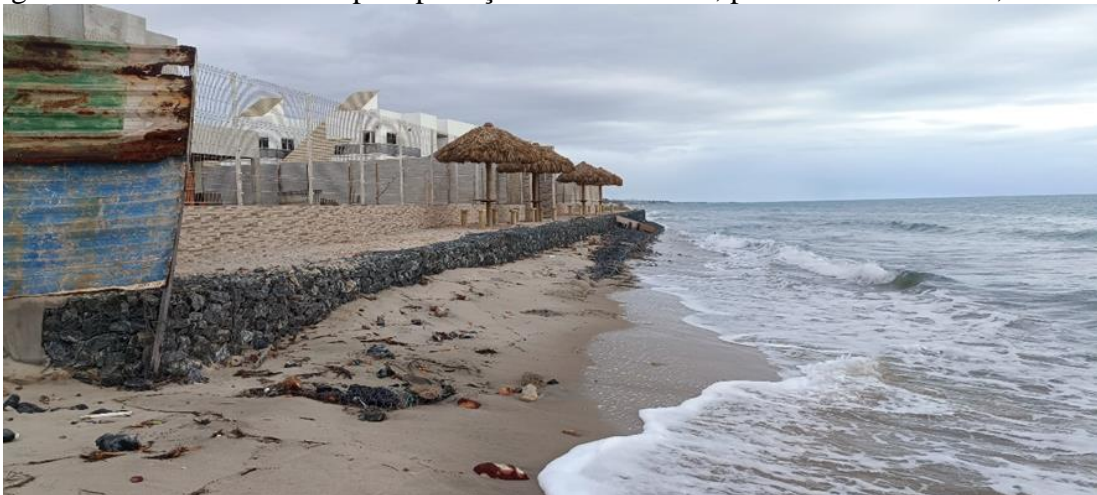
Figura 5: Gabião construído para proteção de residências, praia de Gado Bravo, 2024.
