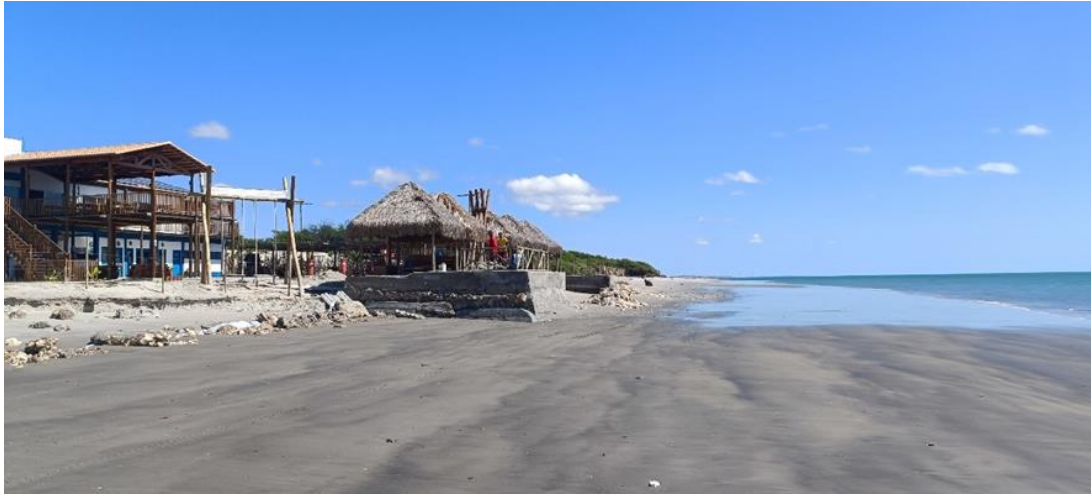
Figura 3: Estrutura construída para proteção da barra de praia na praia de Alagamar, Grossos, 2024.
