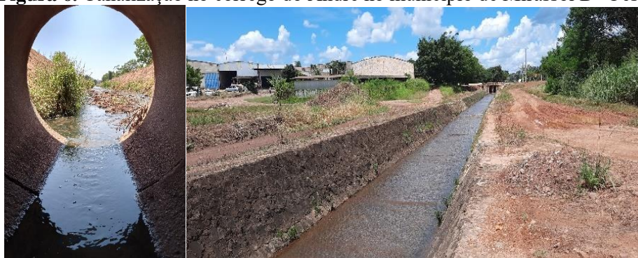
Figura 6. Canalização no córrego do André no município de Mirassol D' Oeste
