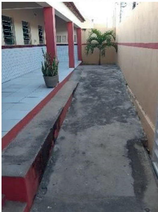
Figura 1- Rampa de acesso principal.
