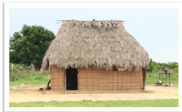
Figura 5 – Habitação de taipa coberta com palhas de buriti Fonte: Dos autores
