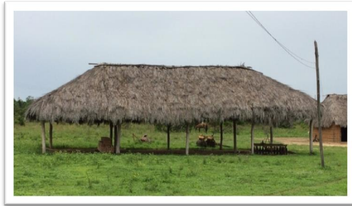
Figura 12 – Barracão com estrutura em estacas de madeira e coberto com palhas de buriti Fonte: Dos autores
