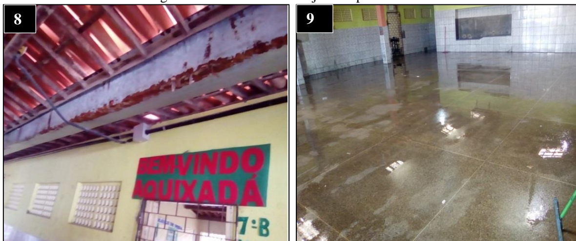
Figura 8 e 9 - Calhas enferrujadas e pátio molhado
