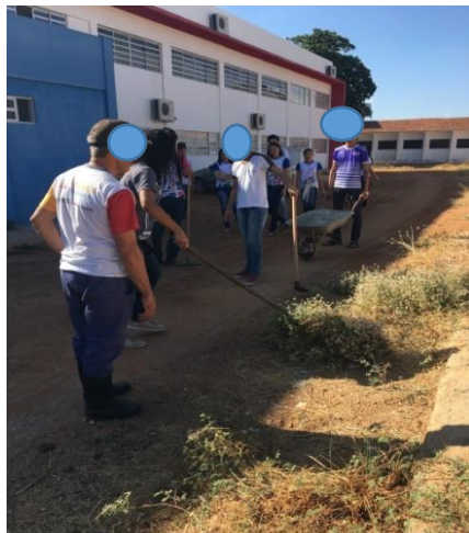
Figura 3 - Organização da área onde foram construídos os canteiros.
