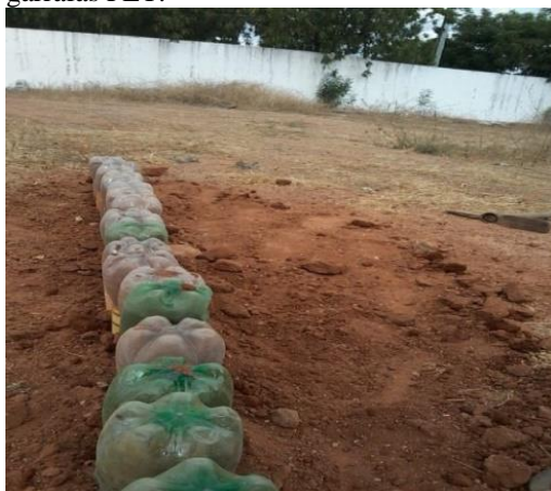
Figura 5 – Construção de canteiros com garrafas PET.
