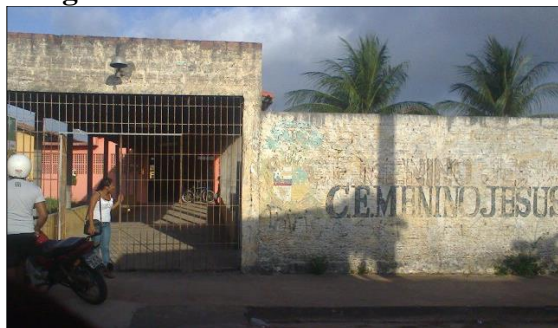
Figura 2 – Fachada da escola em 2015
