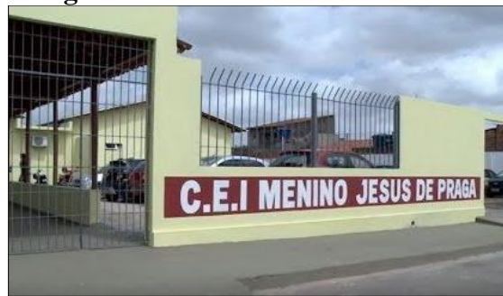
Figura 3 - Fachada da escola em 2019
