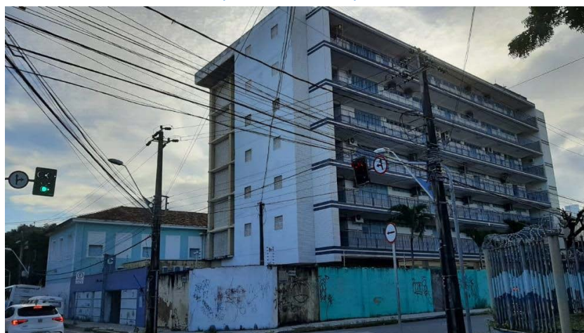
Figura 6. Edifício de seis andares do Colégio Cearense Sagrado Coração que era chamado pelos alunos de prédio novo.
