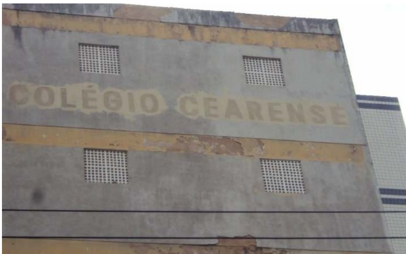
Figura 4. Nome do Colégio Cearense Sagrado Coração escrito na parede externa do prédio de seis andares.
