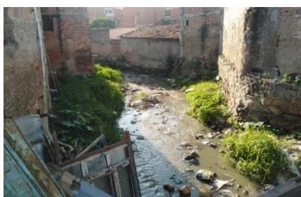
Imagem 1 – esgoto à céu aberto
