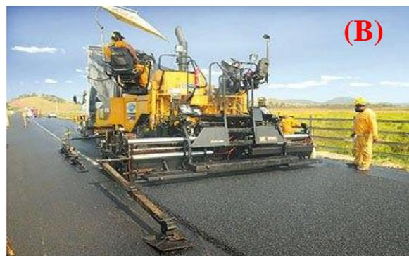
Figura 1 - (A) Pavimento Asfáltico Padrão e (B) Pavimento Asfáltico Borracha. Fonte: Internet.
