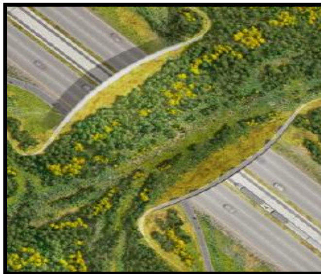
Figura 9. Passagem superior de fauna.
