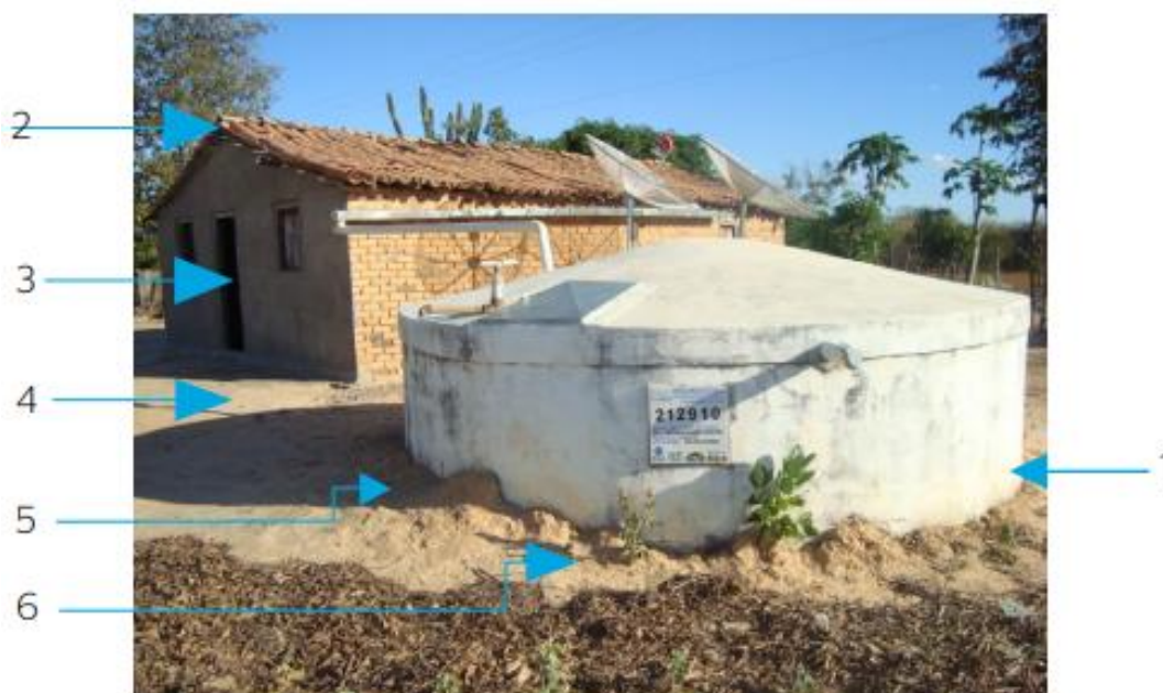
Figura 01 – Cisterna de Placa do PIMC
