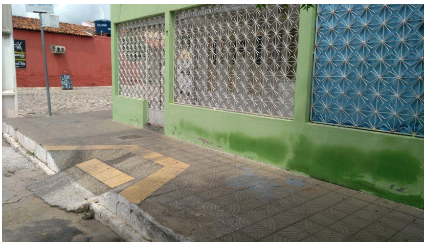
Figura 9: Rampa de Acesso.
