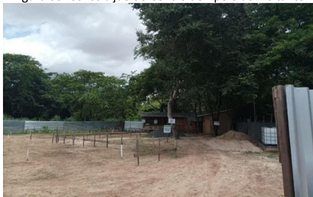
Figura 08: Construção do Centro de Apoio ao Visitante:
